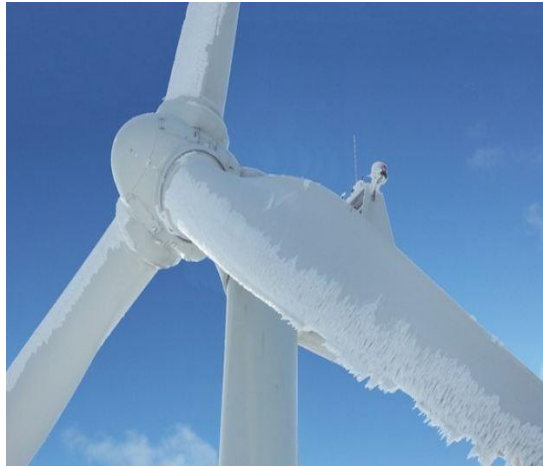
Figure 3.7 Blade icing[60]
