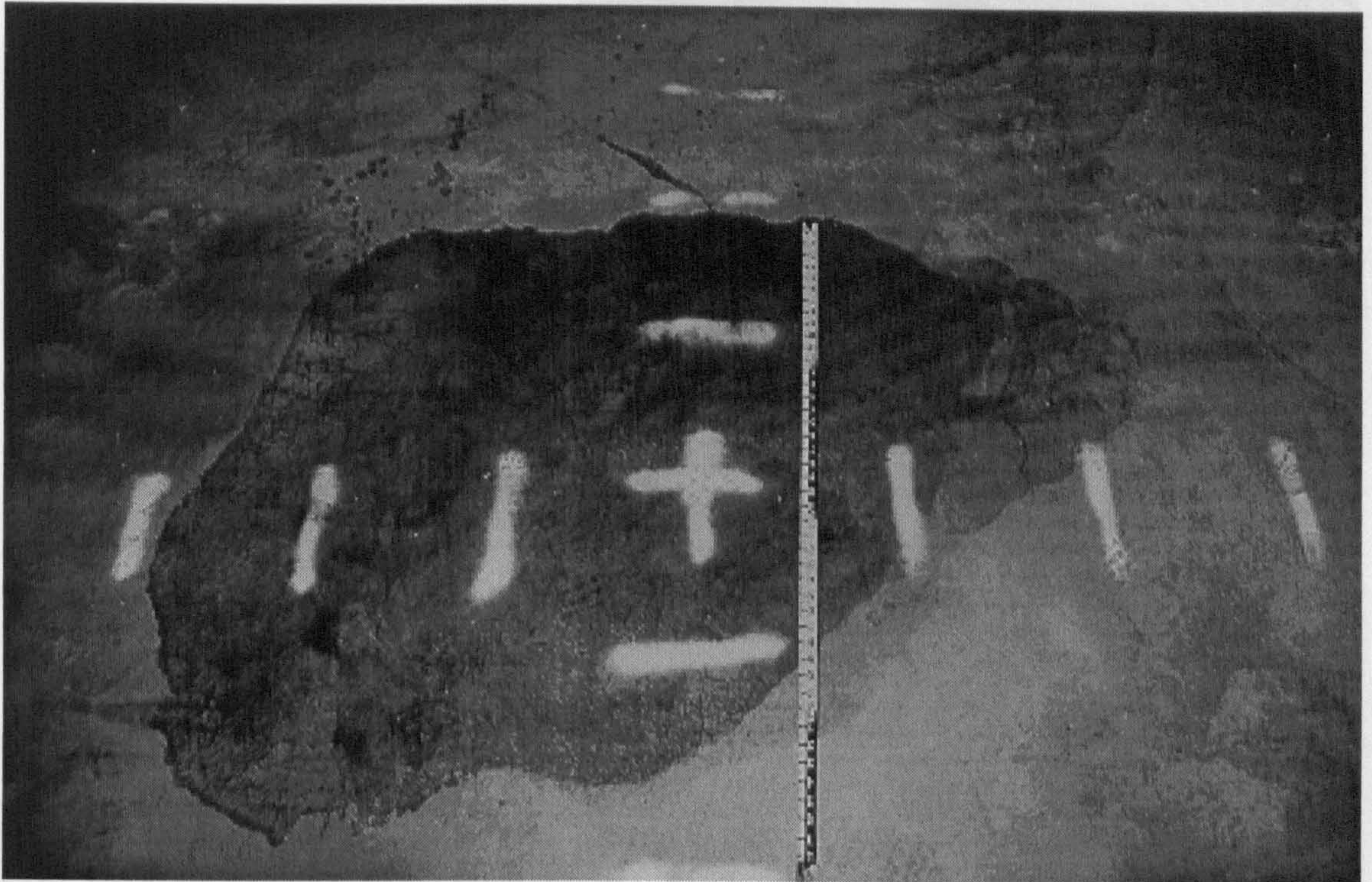
Fig. A.2.1.1: Typical pour test on concrete.
