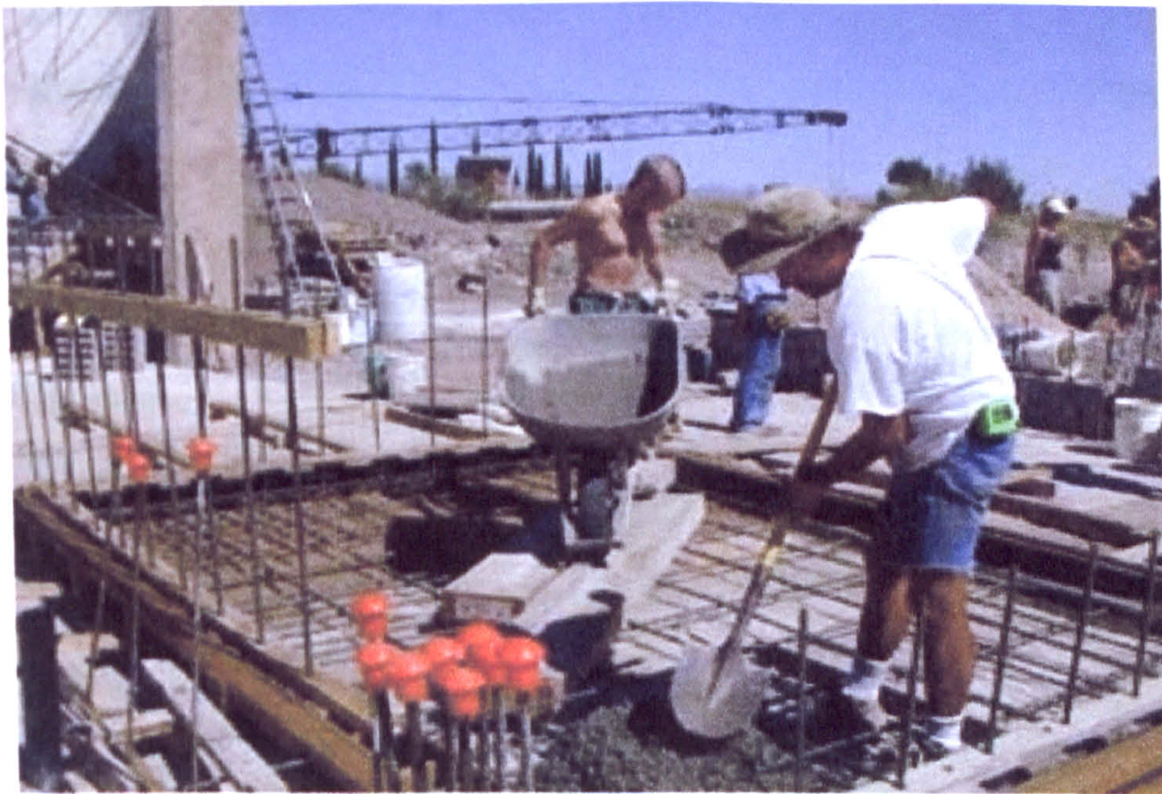
Plate 44 The Daily Concrete Pour
